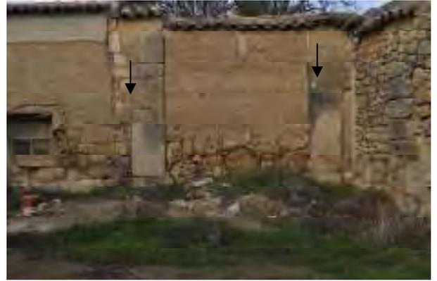
Detalle de la cerca por el Este, obsérvese la existencia de elementos indicativos de la existencia de otras construcciones anteriores como son la parte de las portadas a las que se adosa el muro de mampostería existente en primer plano.
